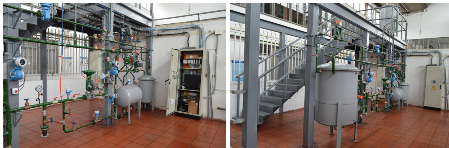
Figura 10.7: Laboratorio de Instrumentación Industrial y Sistemas de Supervisión y Control (LISC)
