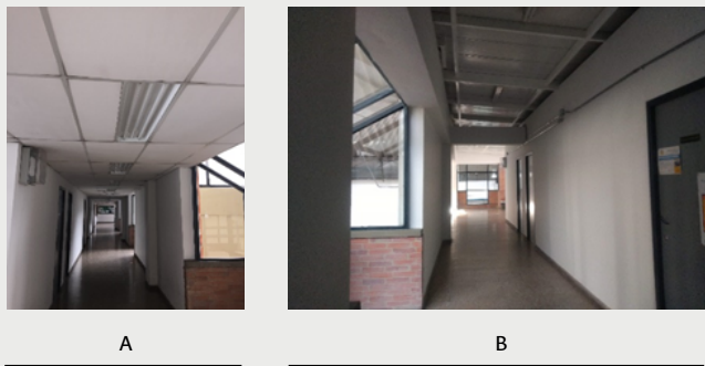
Figura 25. Remodelación Pasillo del edificio 407 de Posgrados de Materiales y Proceso. A) antes. B) después.
