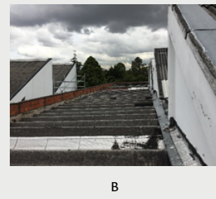
Figura 24. Reparación locativa: cambio de cubierta en la canaleta 90 del edificio 407 de Posgrados
