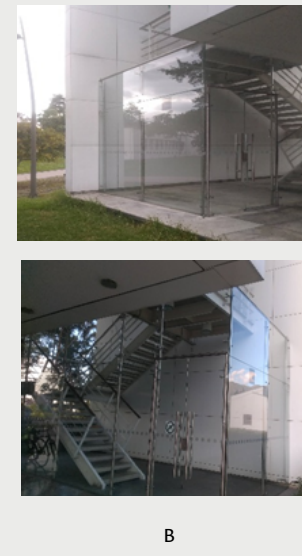
Figura 26. Cortavientos Salidas de emergencia Ed. 454. a) antes b) después
