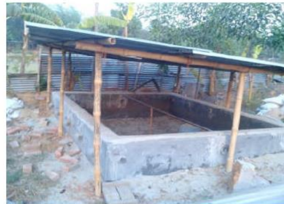
(d) Drying bed 2 with rigid cover
