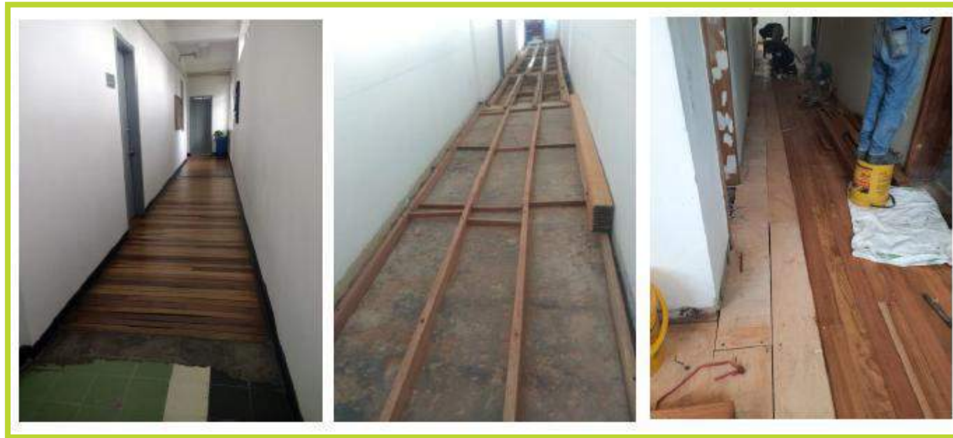
Antes y avance de obra acabado de piso
