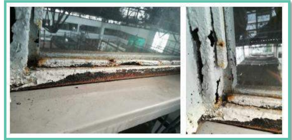
Estado actual ventanería
