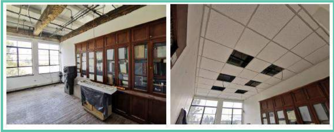
Antes y avance de obra cielo raso
